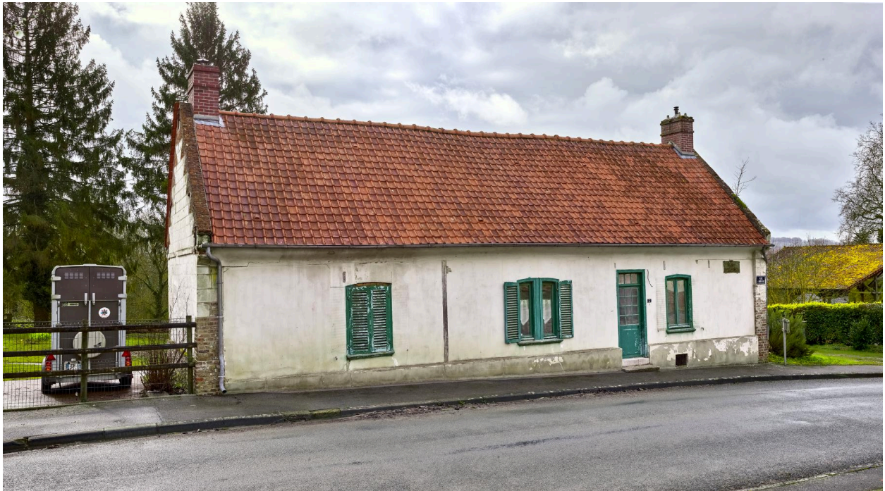
Maison, depuis le nord.
