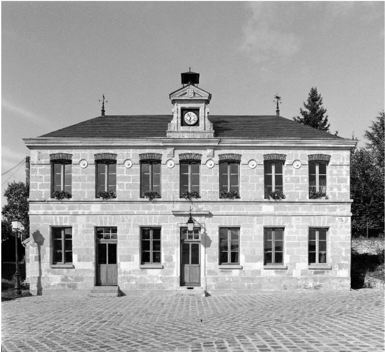
Vue générale de la façade.
