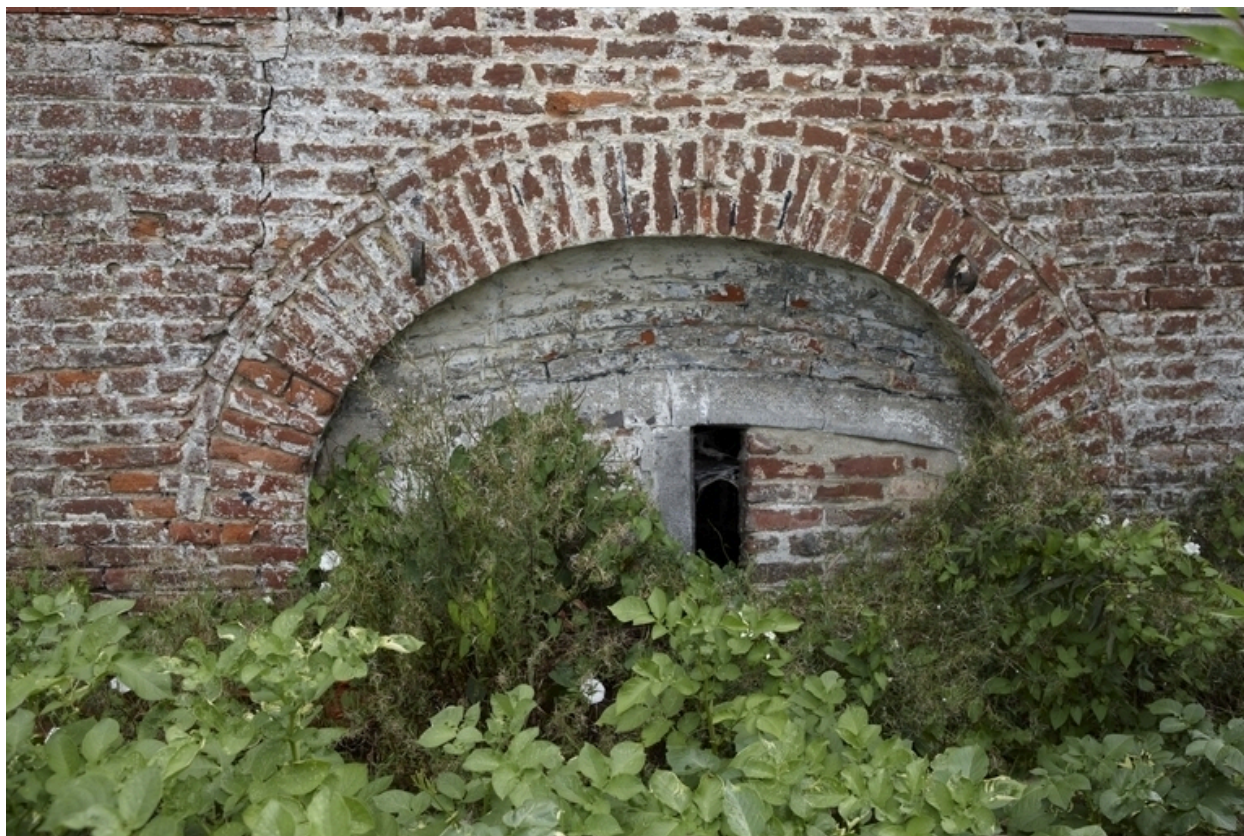
Détail de la blocure située en pignon.
