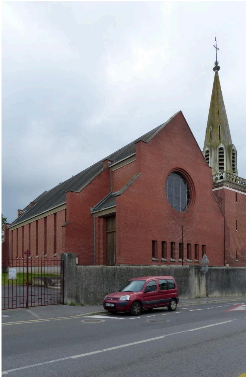
Vue générale, depuis le nord.
