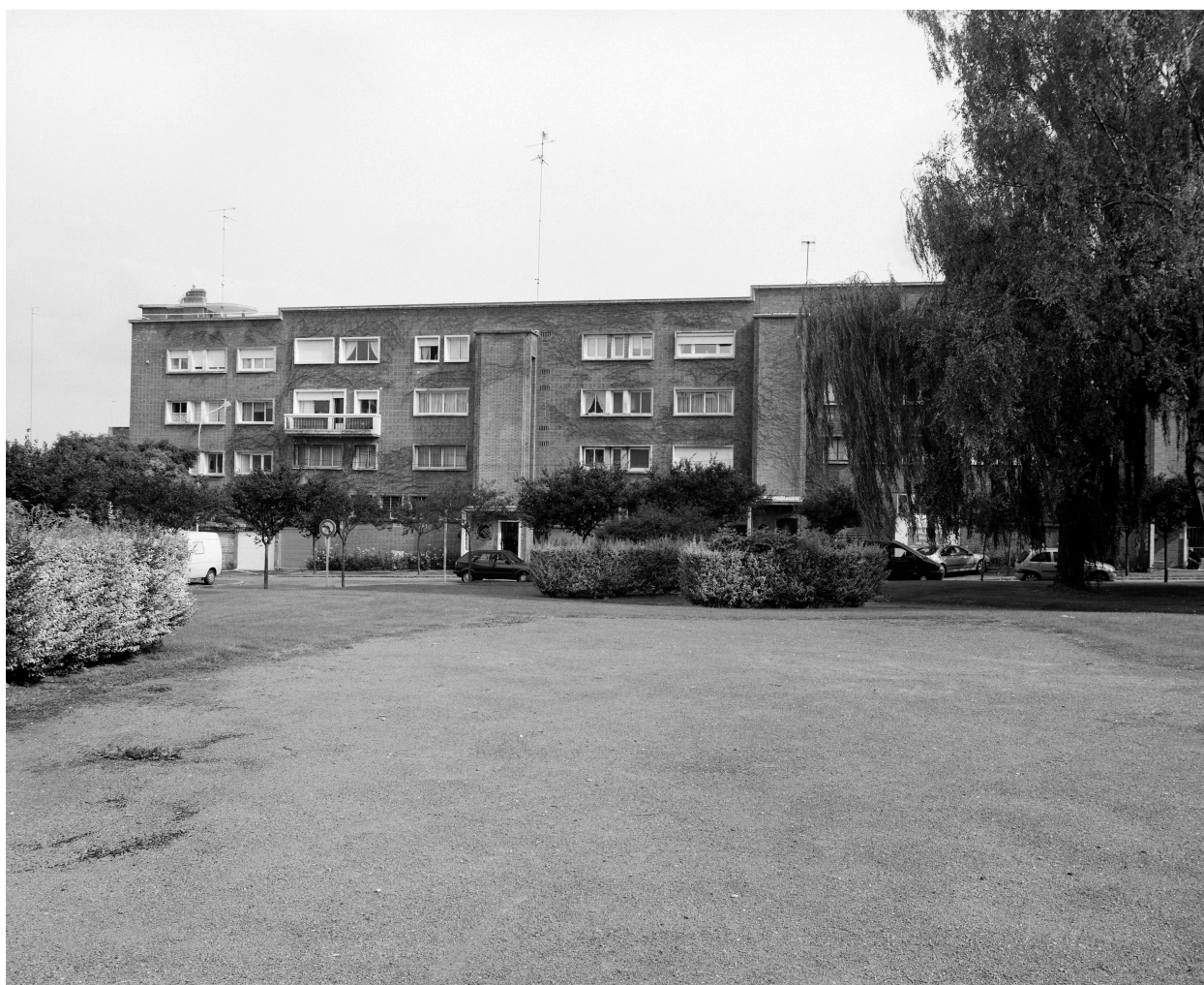
Élévation postérieure du bloc 7 de l'îlot P.
