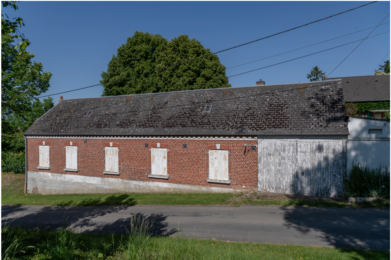
Logis sur rue de la Première Reconstruction (?), n°22 de la rue de l'École, vue depuis l'est.
