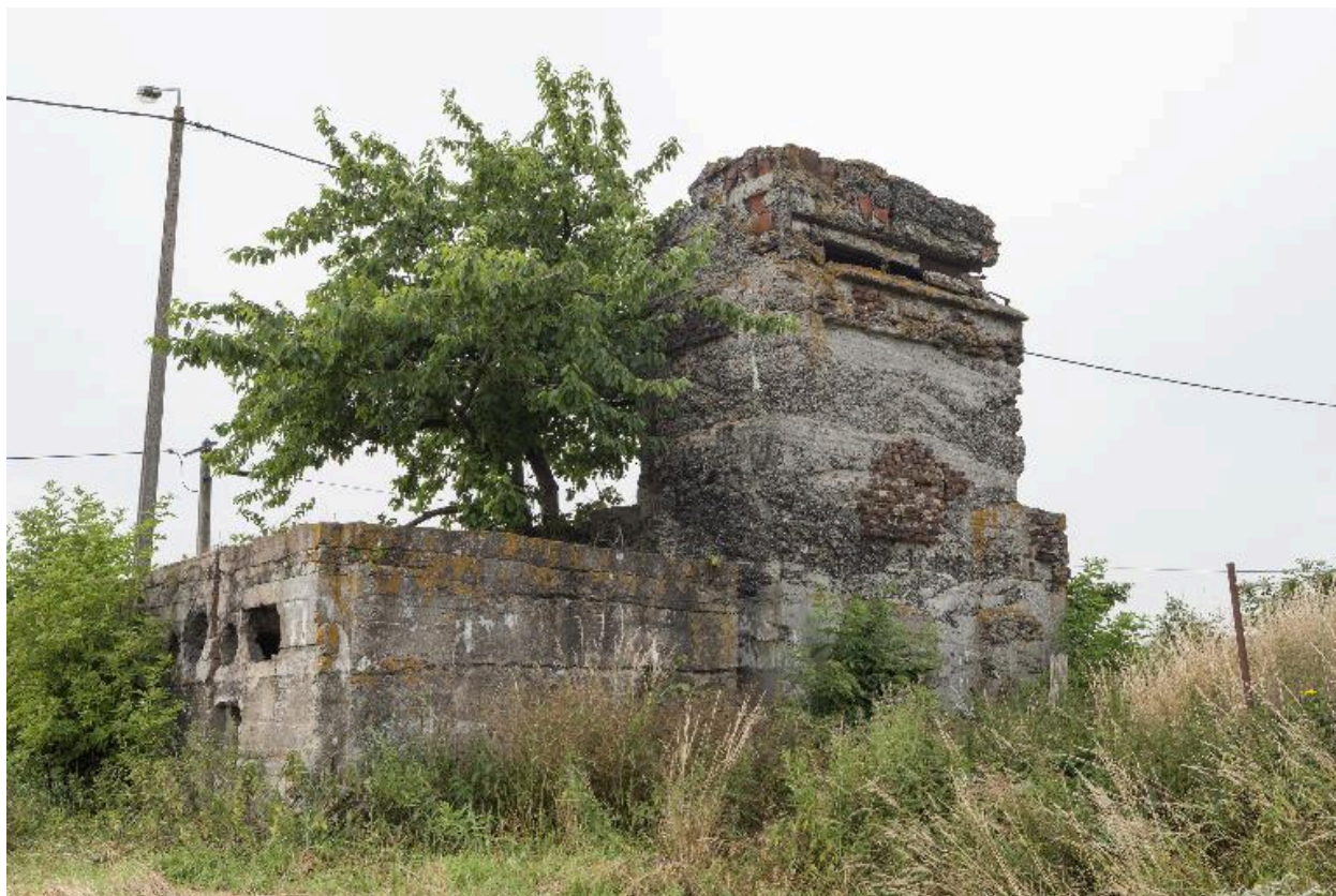
Tour d'observation casematée a, vers le sud-ouest
