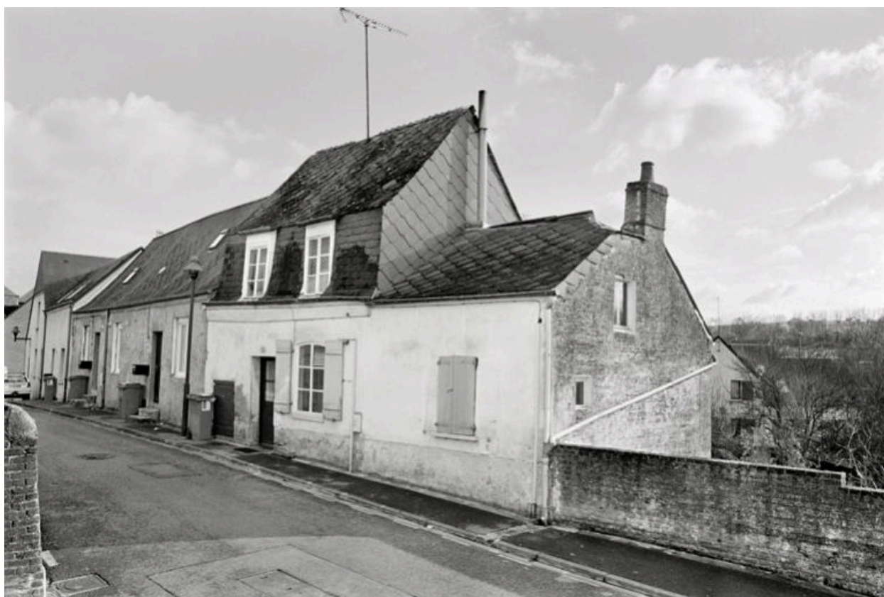
Vue de la façade sur rue.
