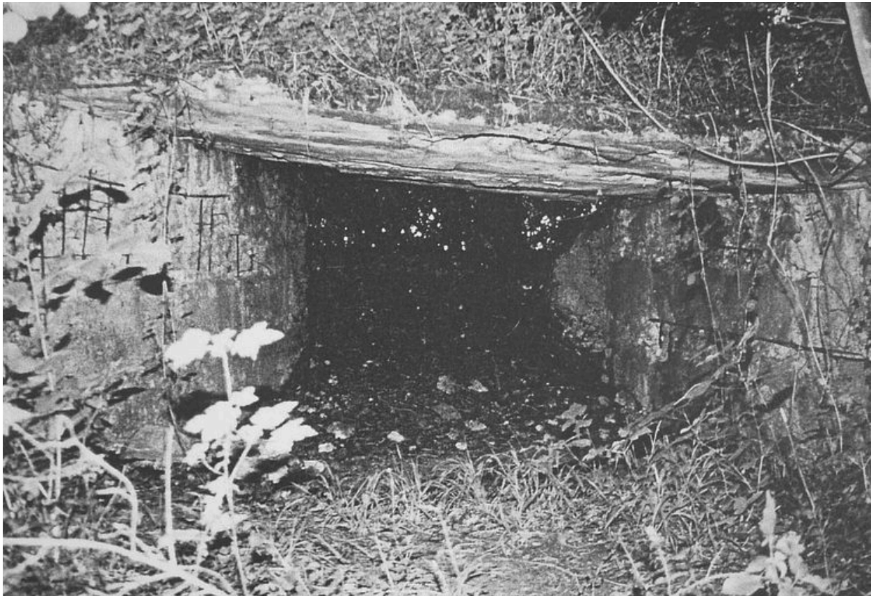
Vue d'un abri en béton armé.
