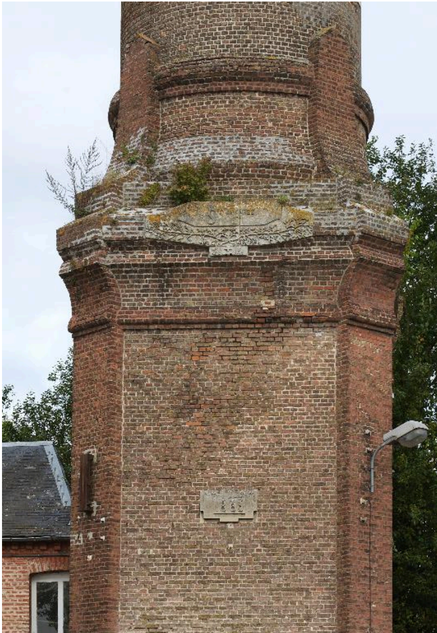
Détail de l'inscription et de la date présente sur la base de la cheminée.
