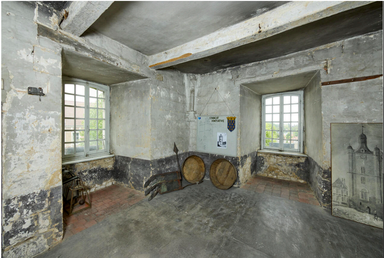
Vue intérieure de la salle du Conseil d'échevinage au premier étage du beffroi.
