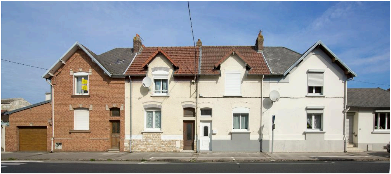
Groupe de quatre logements. Vue générale des façades des numéros 25 à 31 depuis la rue Marcelin-Gaudefroy.
