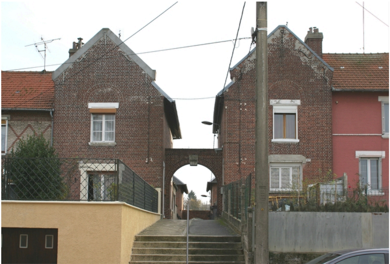
Entrée de la ruelle piétonnière, rue du Docteur Cordier.
