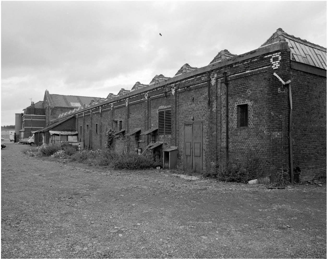
Magasin aux déchets et embranchement ferroviare. Vue prise vers l'ouest.
