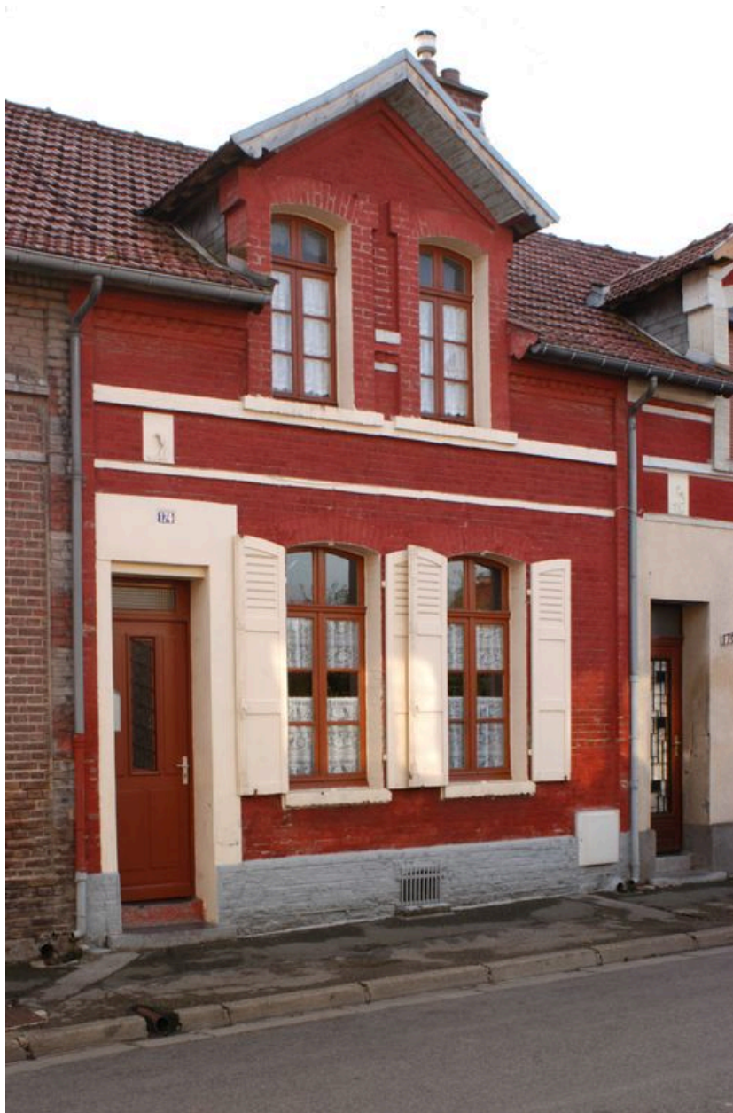
174 rue Jean-Catelas, maison dite Le Chapentier, construite en 1923.
