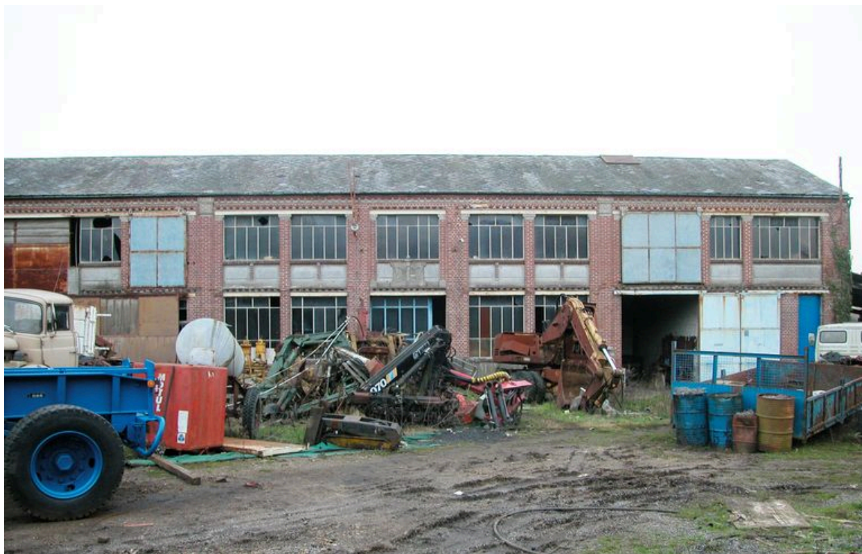
Atelier de fabrication, façade sur cour.
