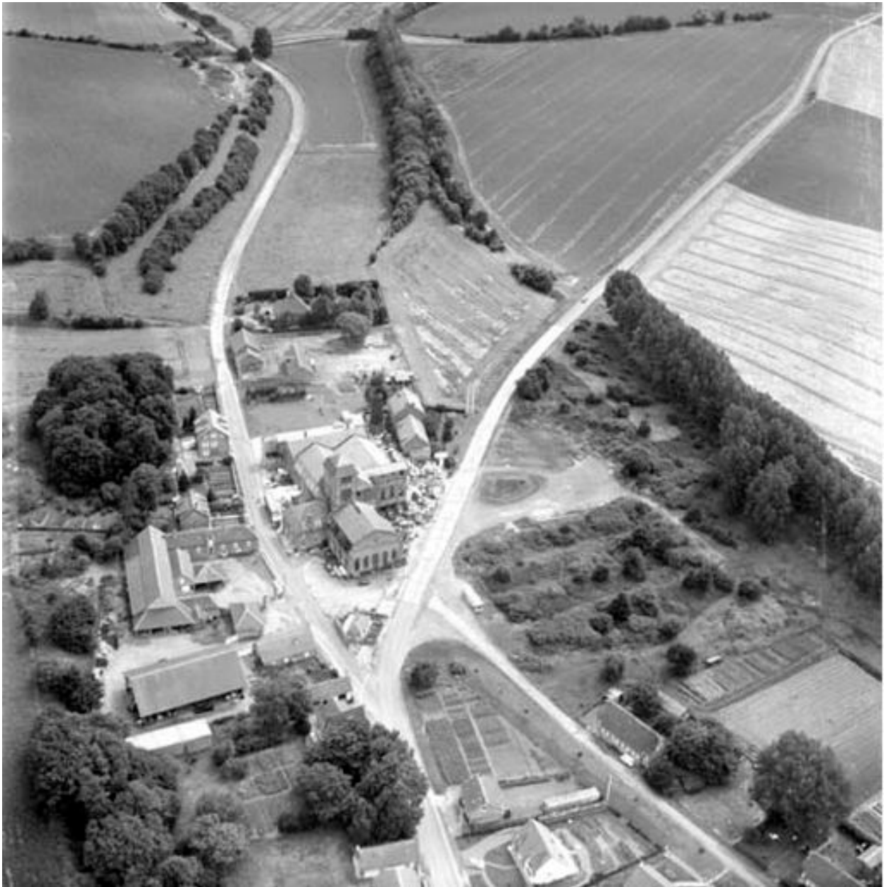
Vue aérienne, flanc nord.
