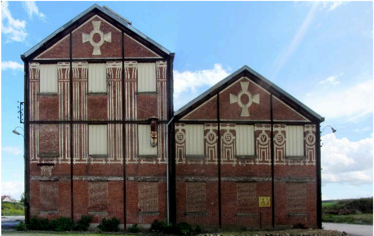
Vue d'ensemble de la façade ouest de la râperie.
