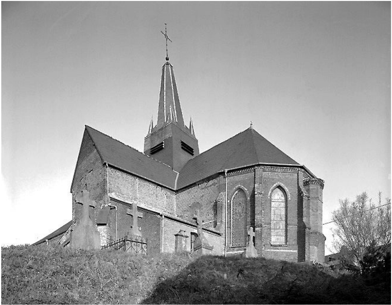
Vue depuis le sud-est.
