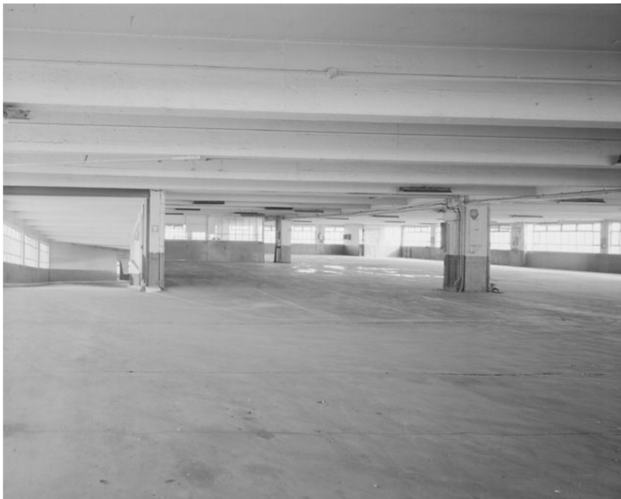
Vue d'ensemble du niveau 3.
