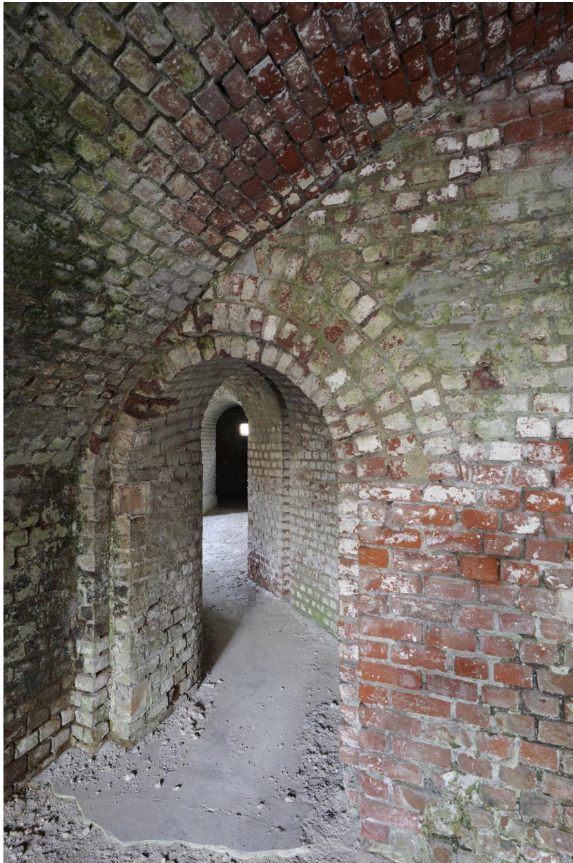
Sous-sol de caserne de gorge. Caserne de flanquement est. Couloir d'accès à la deuxième salle.
