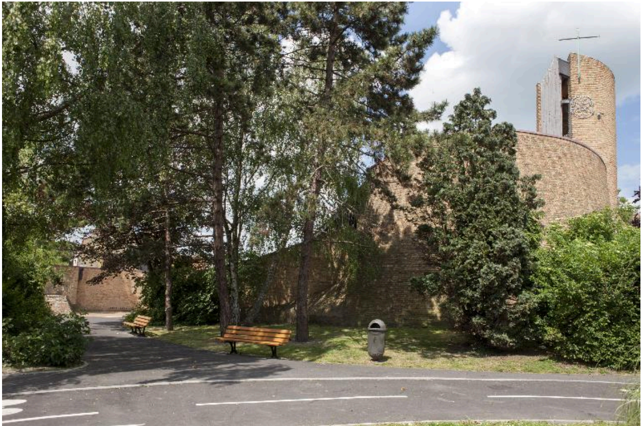
Élévation du flanc droit de l'église.
