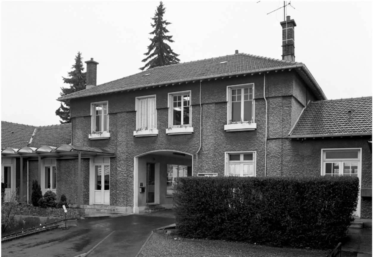
Les bureaux, façade est.
