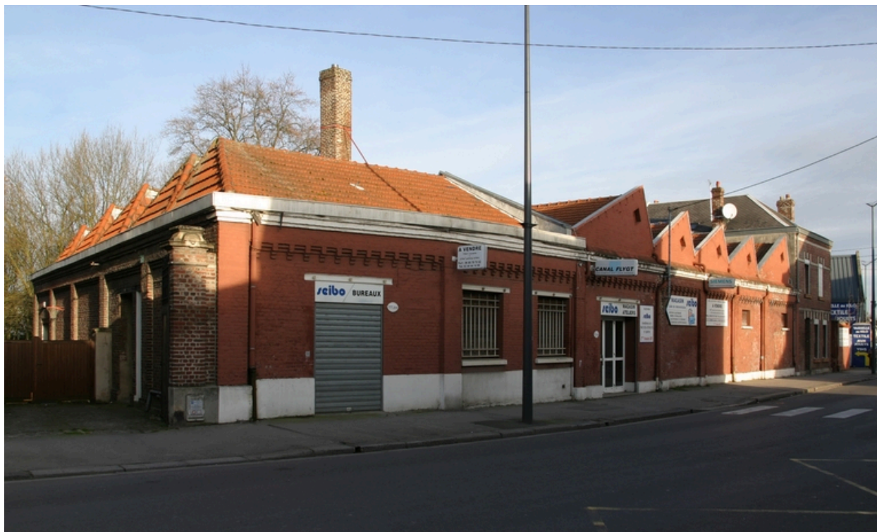
Façade antérieure des ateliers.
