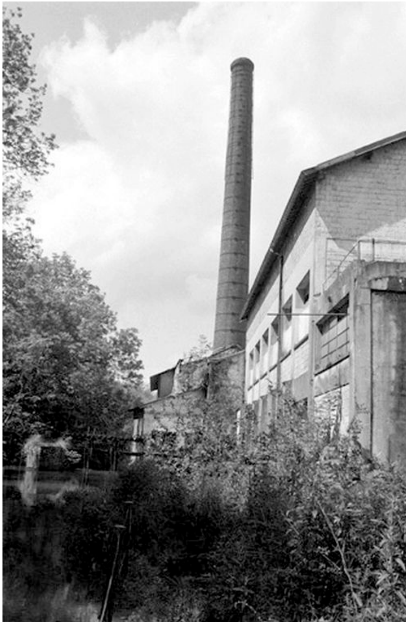
Atelier de fabrication sud, bâtiment d'eau et cheminée d'usine.
