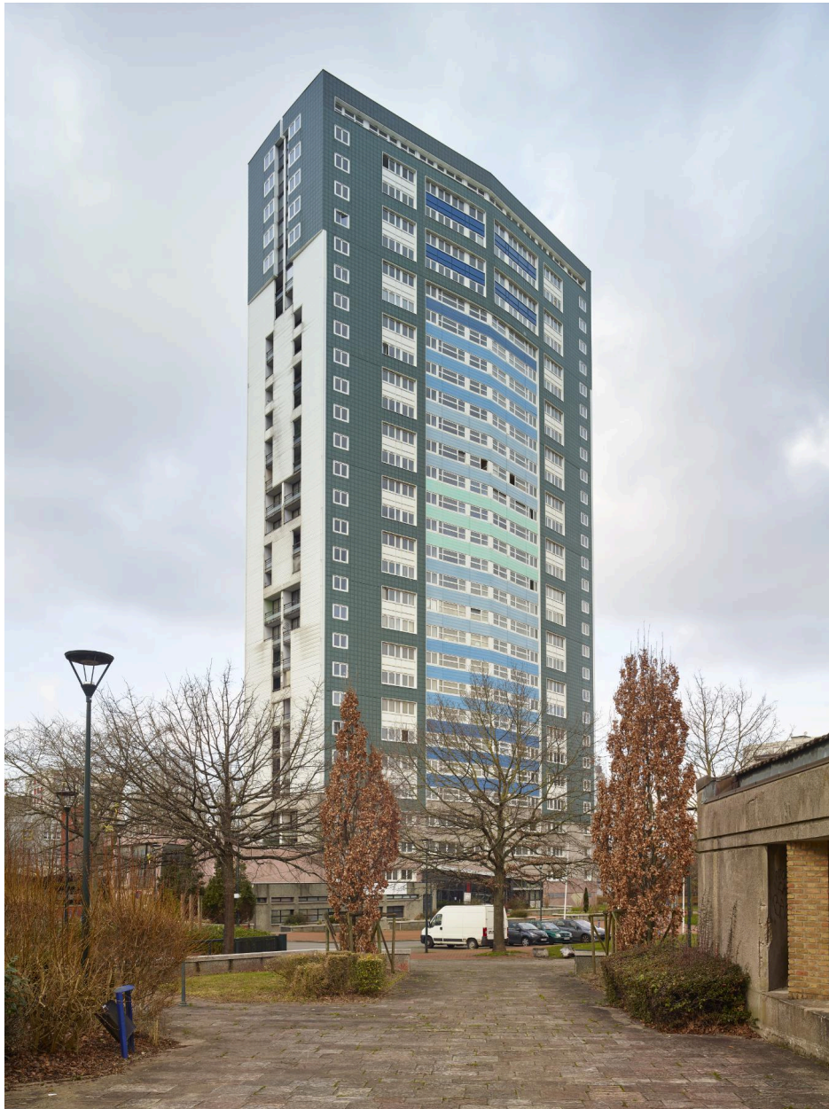
L'angle sud-est depuis le parvis de l'église de la Sainte-Trinité.
