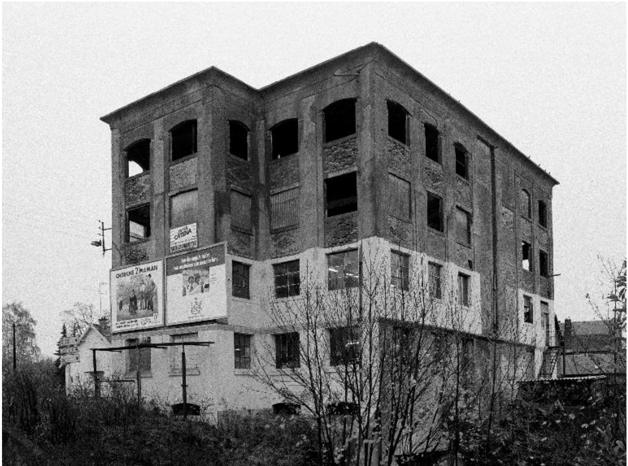
Vue d'ensemble sur cour de la minoterie en 1990.
