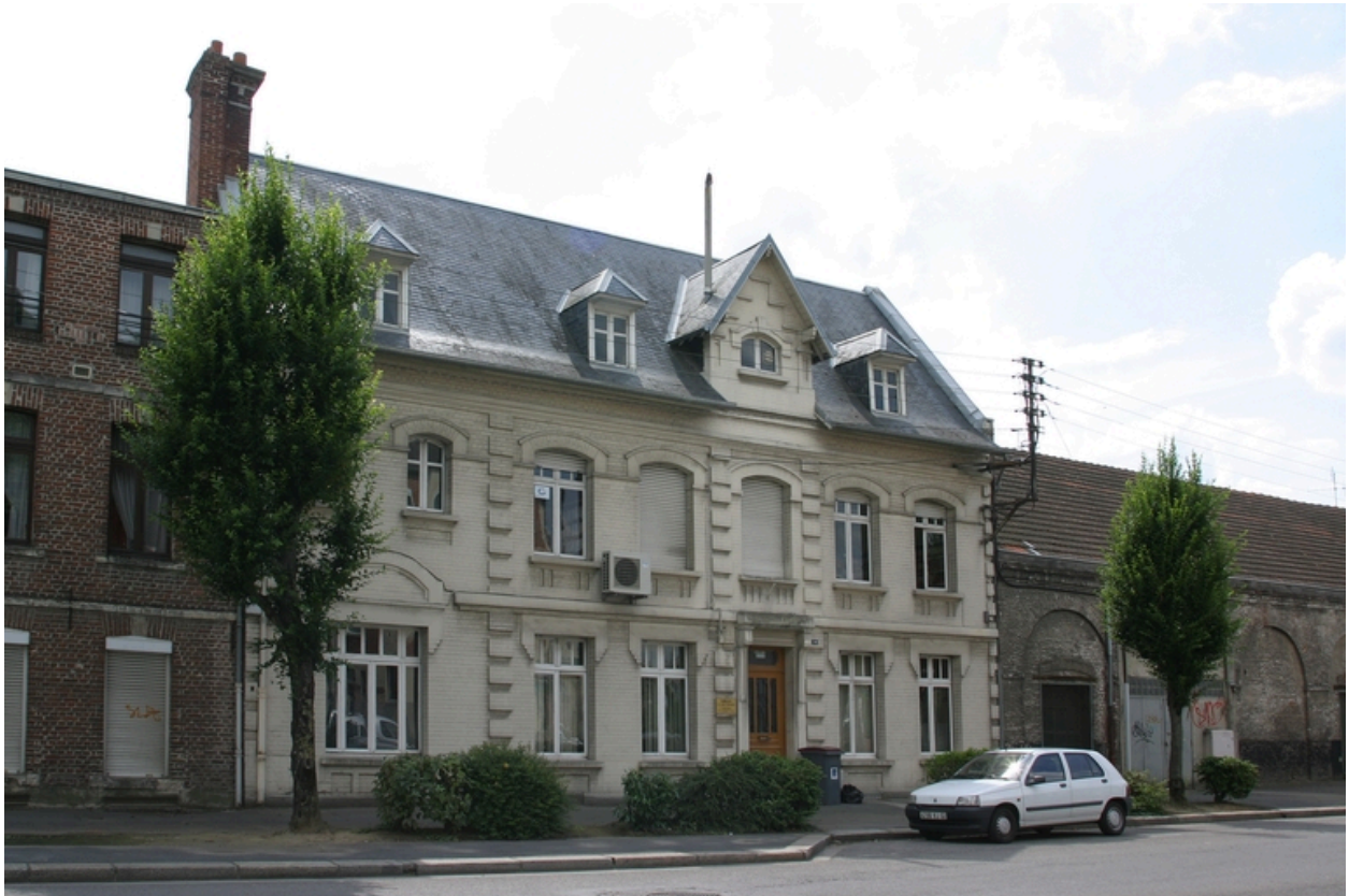
Ancien logement du directeur : façade antérieure.
