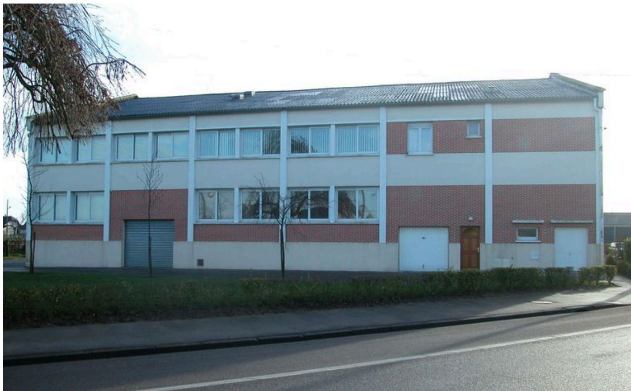
Façade nord de la laiterie.
