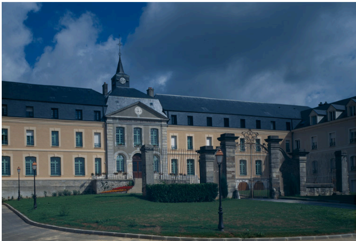
La grille d'entrée.
