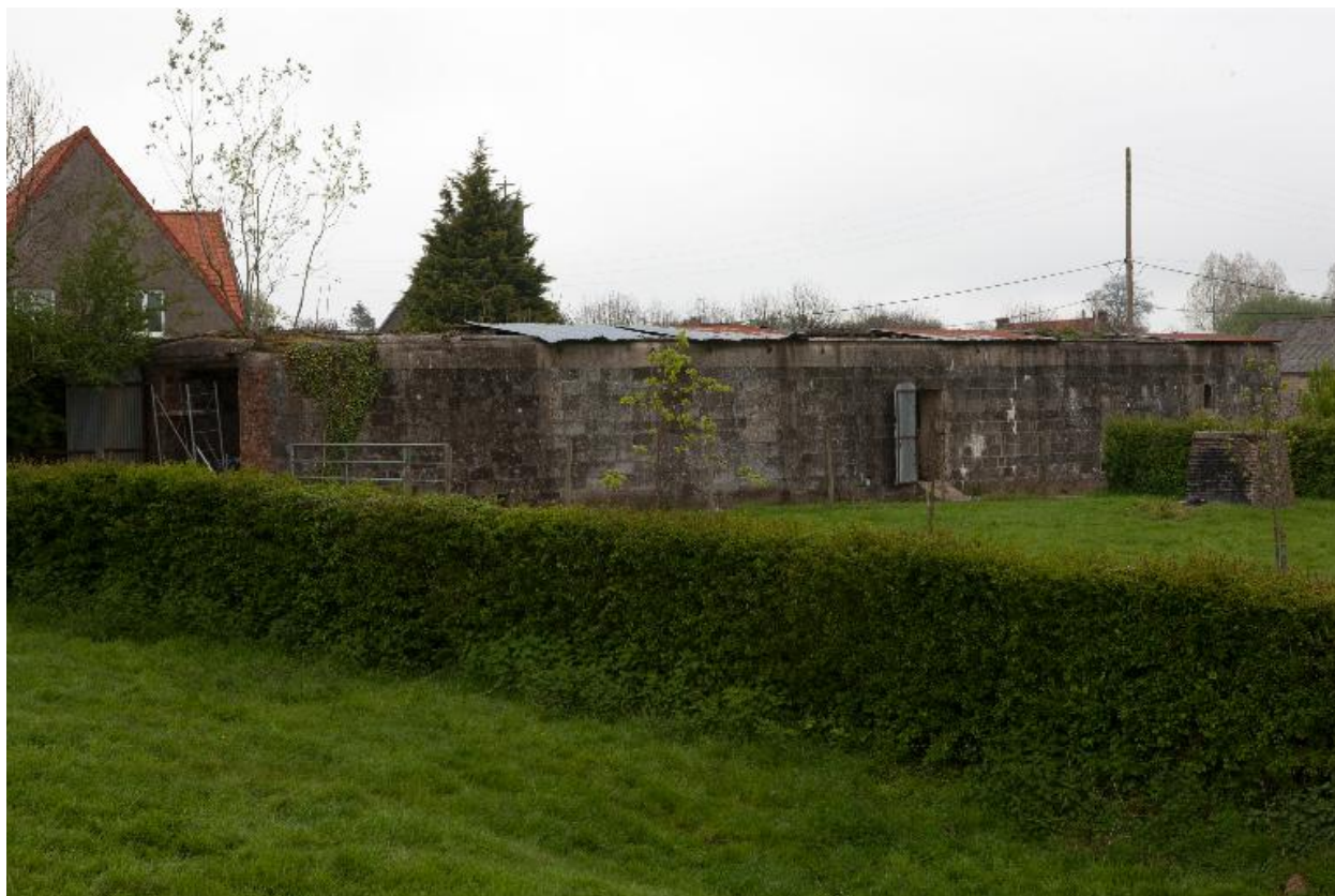
Bâtiment de stockage d'attente. Vue générale.
