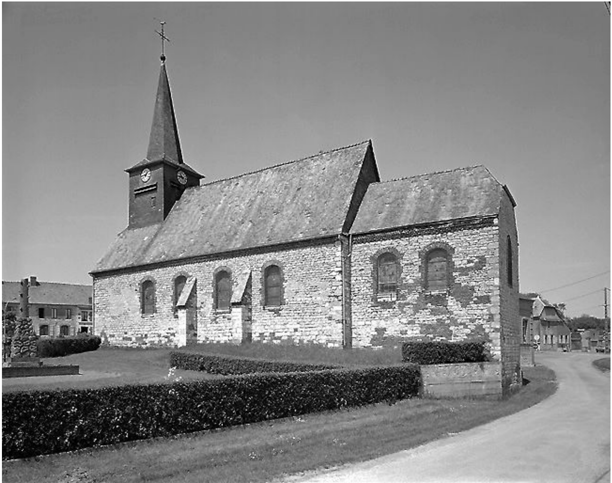
Nef et choeur depuis le sud-est.
