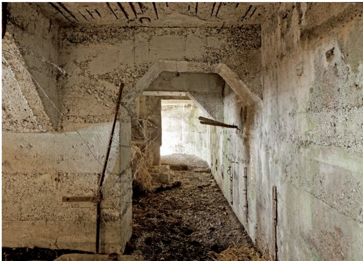
Couloir, vers l'ouest
