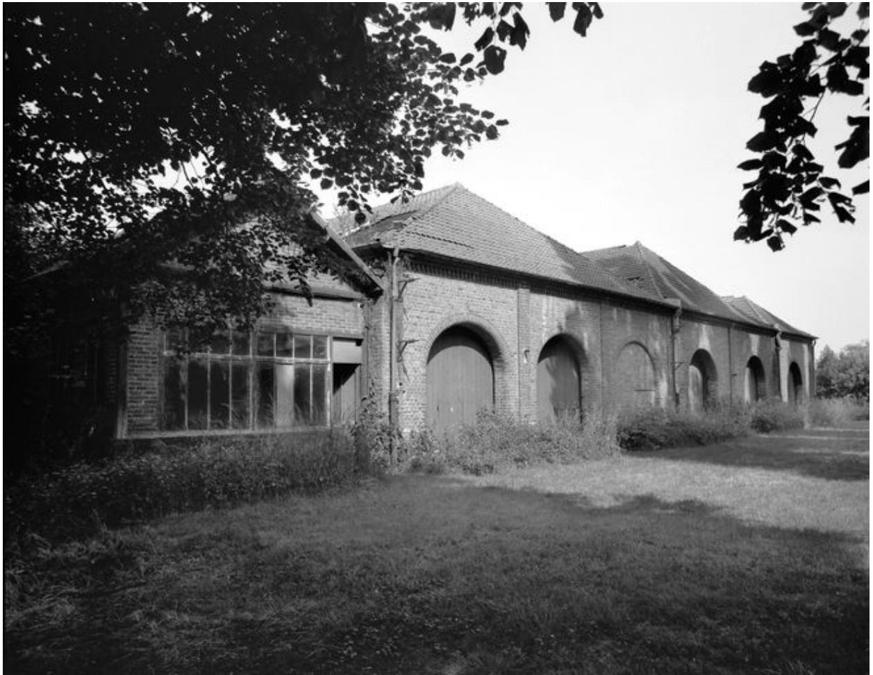
Scierie, en 1989 : élévation est.
