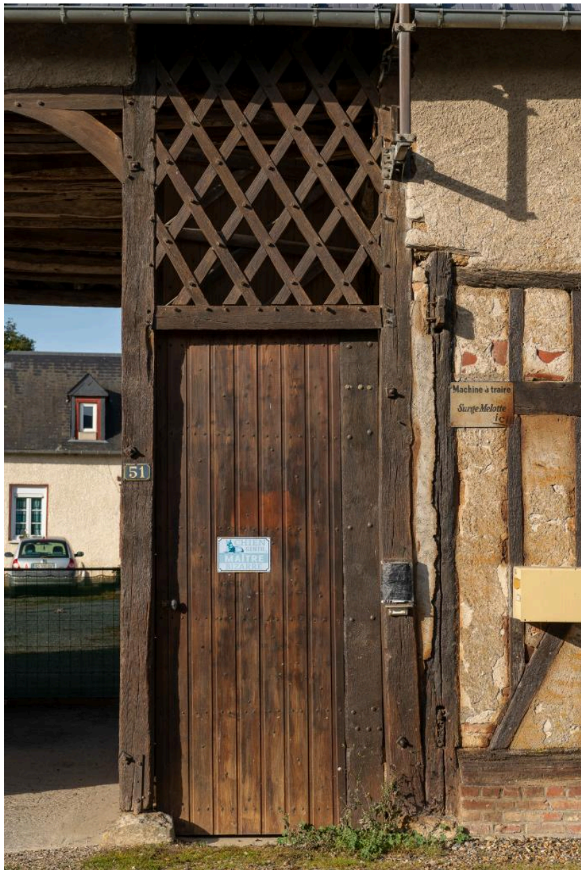
Détail de la porte piétonne avec imposte ajourée, n°51 rue Principale, vue depuis l'est.
