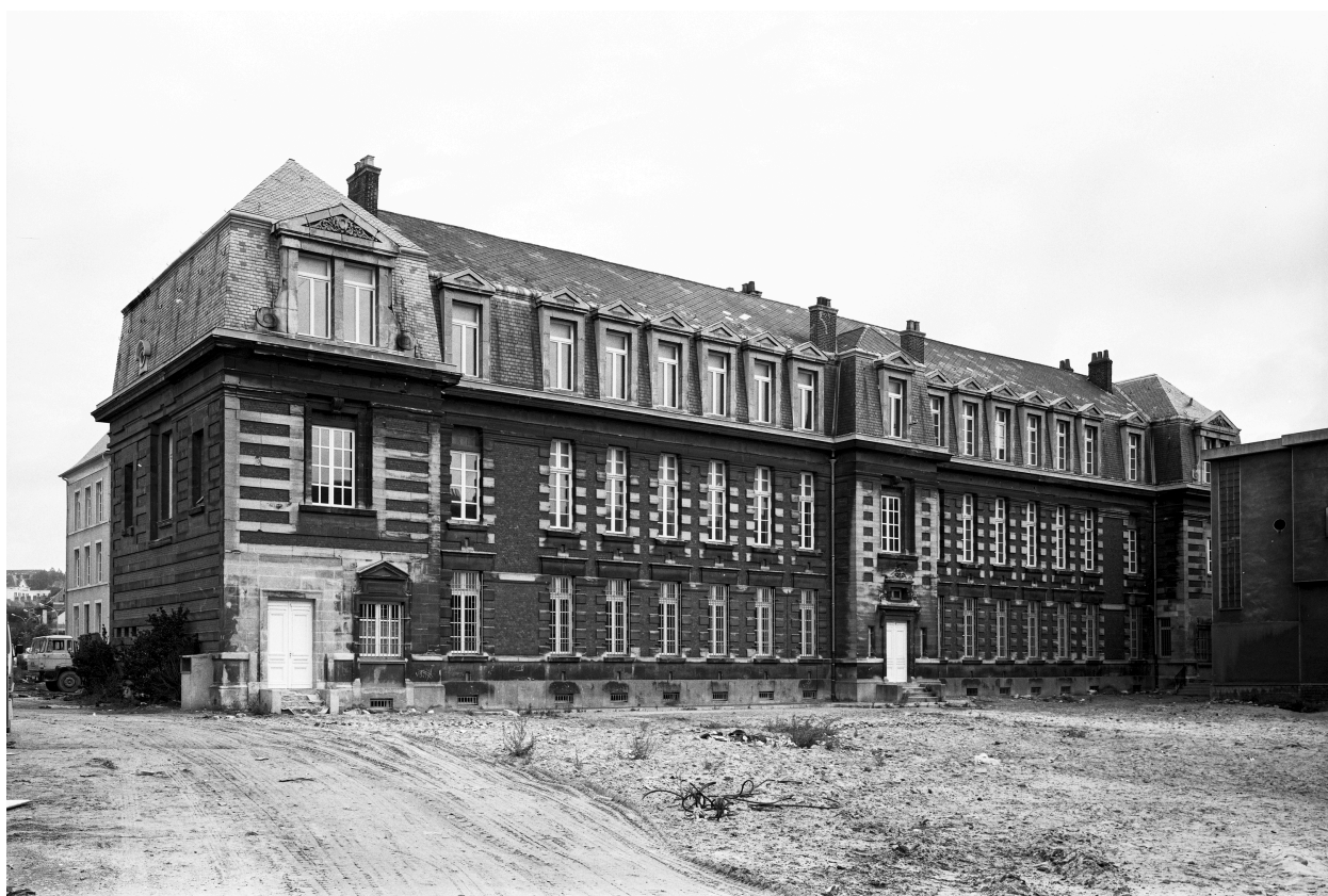
Vue d'angle sud-ouest.
