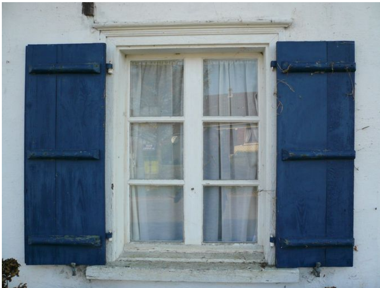
Vue détaillée d'un entablement de fenêtre.
