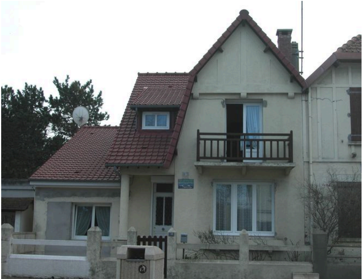
Les Brisants, élévation antérieure.
