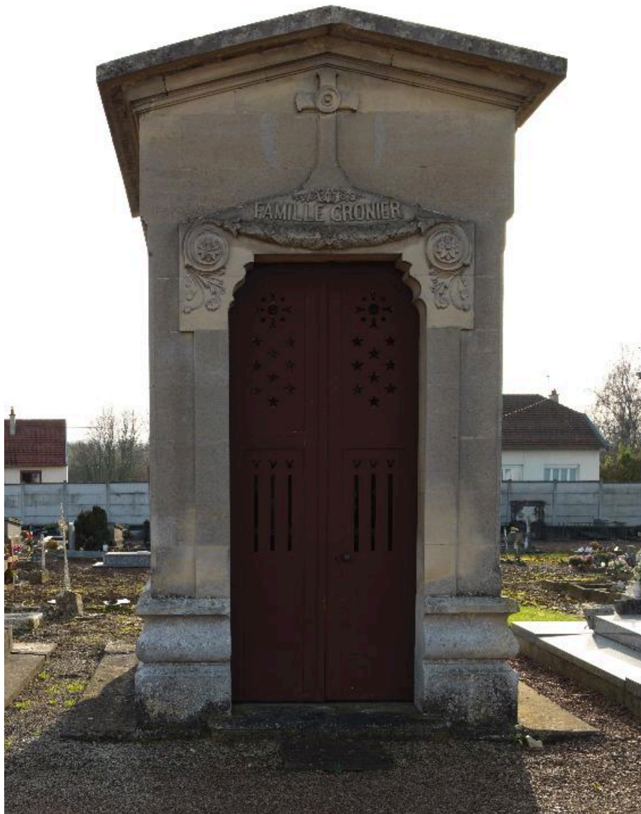
Vue de la façade antérieure.
