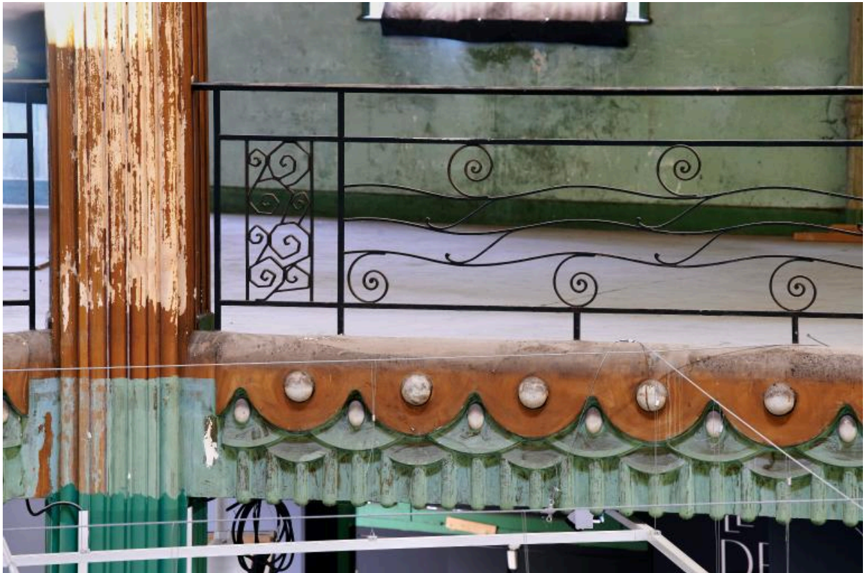
Détail partiel du garde-corps du second étage de l'atrium ovale et de son décor stucqué en bas-relief festonné.
