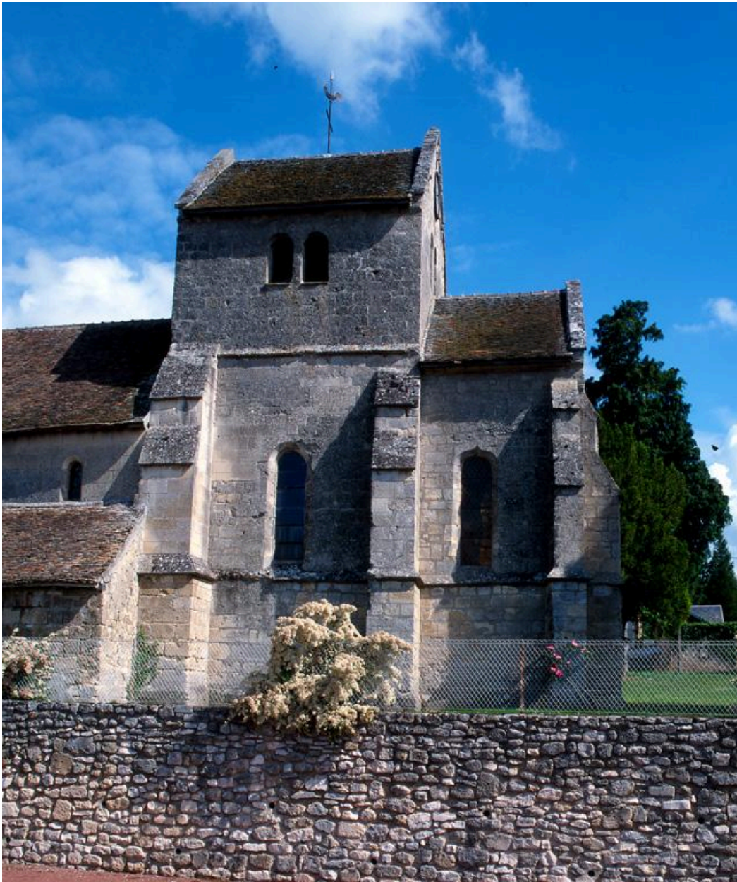
Vue extérieure du transept sud.
