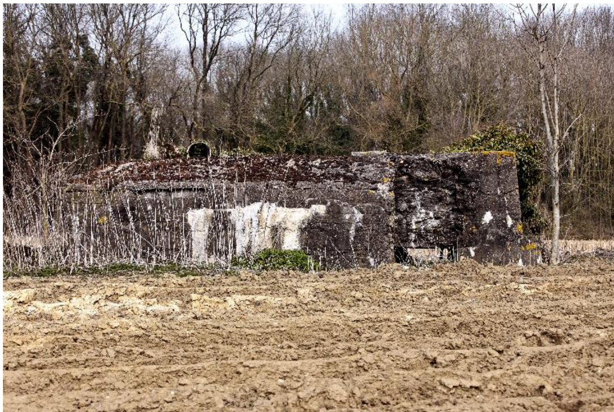
Vue générale vers le nord-est
