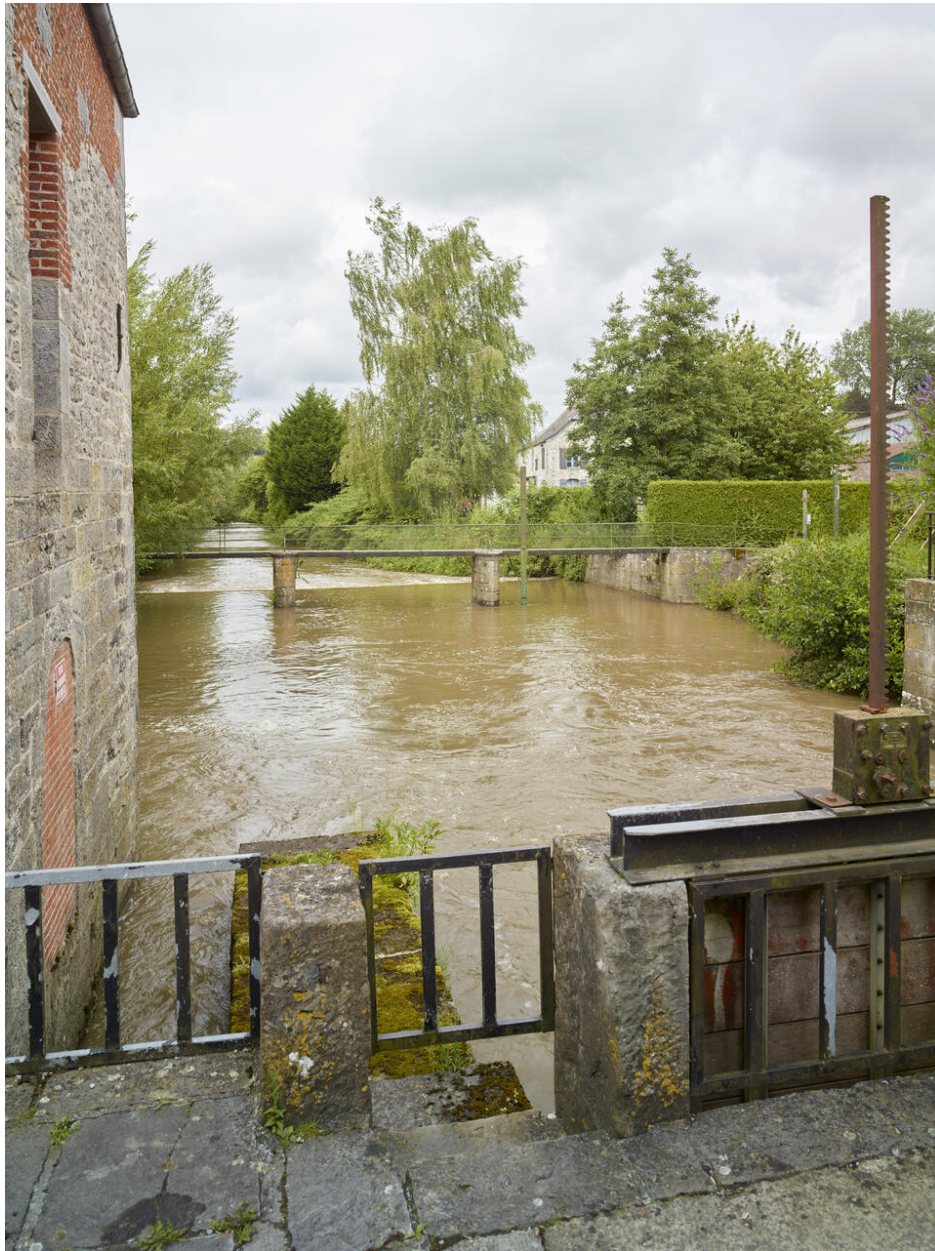
L'Helpe-Mineure. Vanne au premier plan et passerelle.
