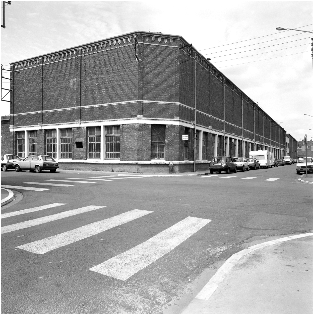
Élévation. Vue prise vers le nord-ouest, depuis la rue de la Paix.
