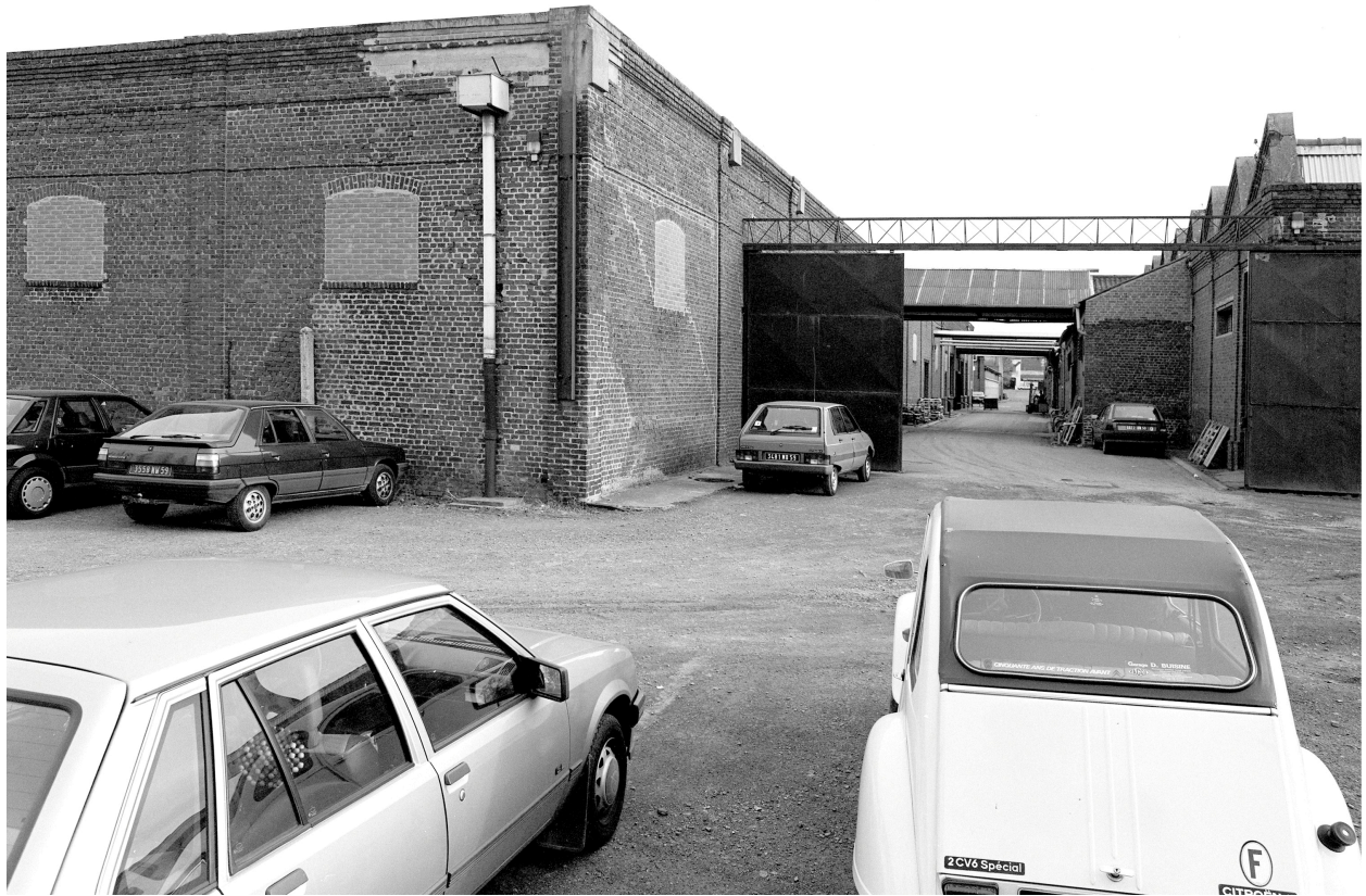
Atelier de fabrication, vue générale vers le sud.
