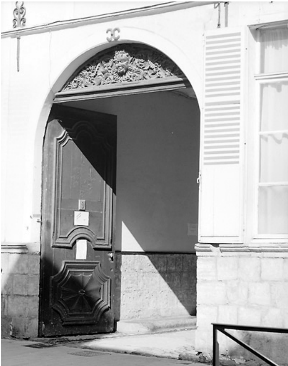
Façade rue Notre-Dame, porte cochère : vue générale.
