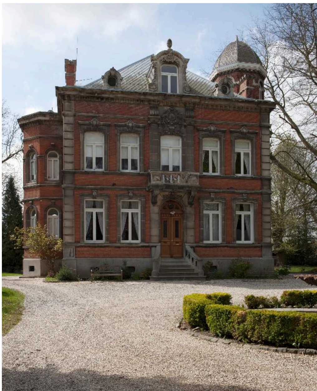
Maison de maître, 94, rue de Mortagne.
