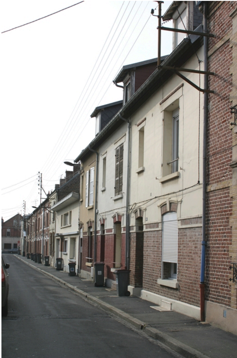
Groupe de 3 logements.
