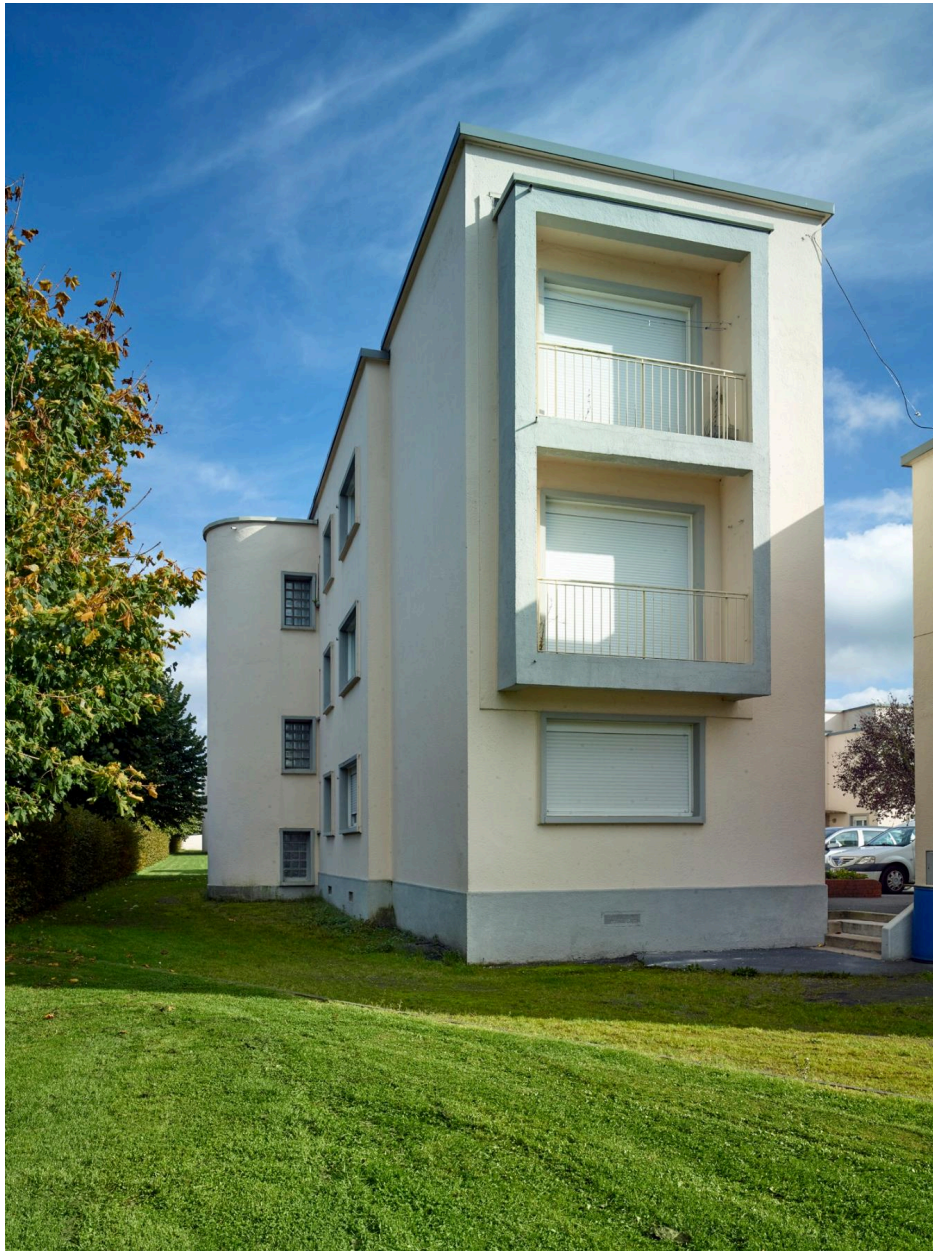
Vue latérale d'un immeuble collectif.
