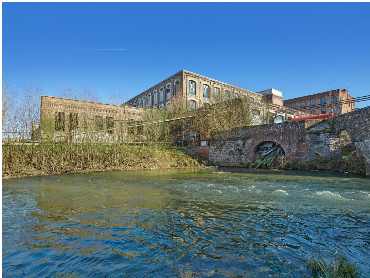
Vue de l'ancienne filature depuis la rive de l'Authie.
